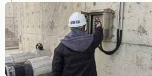
与此同时安排人员启动污水排放回流泵，外排污水打入事故应急池
